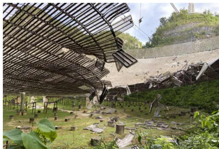
Lo specchio principale distrutto dalla caduta, il 1 dicembre 2020, della struttura sospesa del radiotelescopio.
